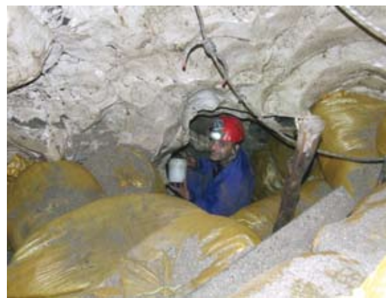
A causa delle piene invernali che periodicamente ostruivano un punto della grotta, si è resa necessaria la costruzione di una palizzata con sacchi di sabbia.
